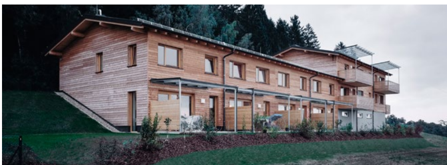
Bilder: geförderte Wohnbauprojekte in konstruktivem Holzbau in der Max-Mell-Allee, Linz (Bild 1 und 3) sowie St. Lorenzen am Wechsel (Bild 2). Planung Nussmüller Architekten, Linz; ©Fotografie Simon Oberhofer
